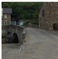
De oude brug
